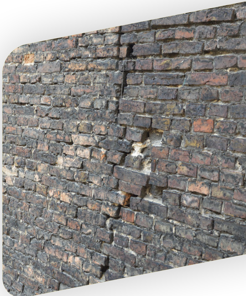
il. 5. Badania makroskopowe muru ścian zewnętrznych - rozległe zabrudzenia elewacji.
