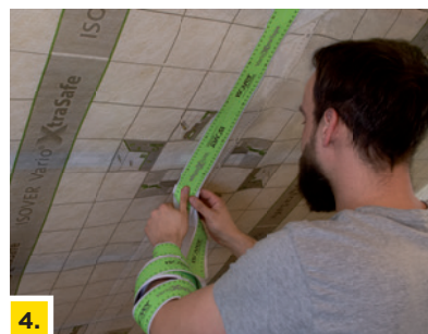
4. Zaklejenie zakładów folii taśmą połączenia typu „rzep”
