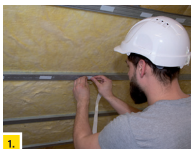
1. Przyklejanie rzepów ISOVER Vario® XtraPatch do profili metalowych.
