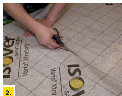
2. Przycinanie na wymiar folii ISOVER Vario® XtraSafe, korzystając ze znaczników.
